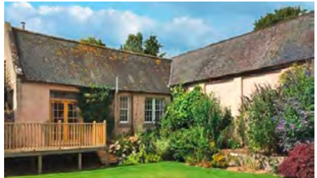
LITTEL FYRISH COTTAGE
